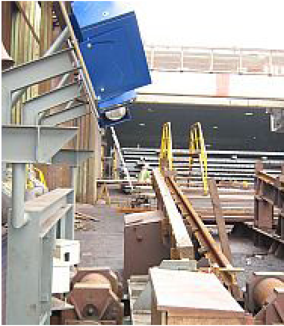
Identifikationsanlage in einem Walzwerk
